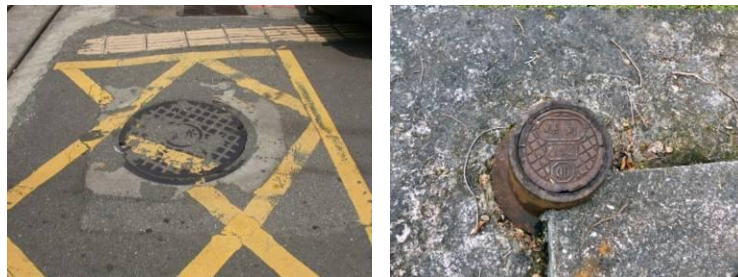
圖 1-4 公用管線孔蓋之人孔蓋（左）及制水閘（右）
