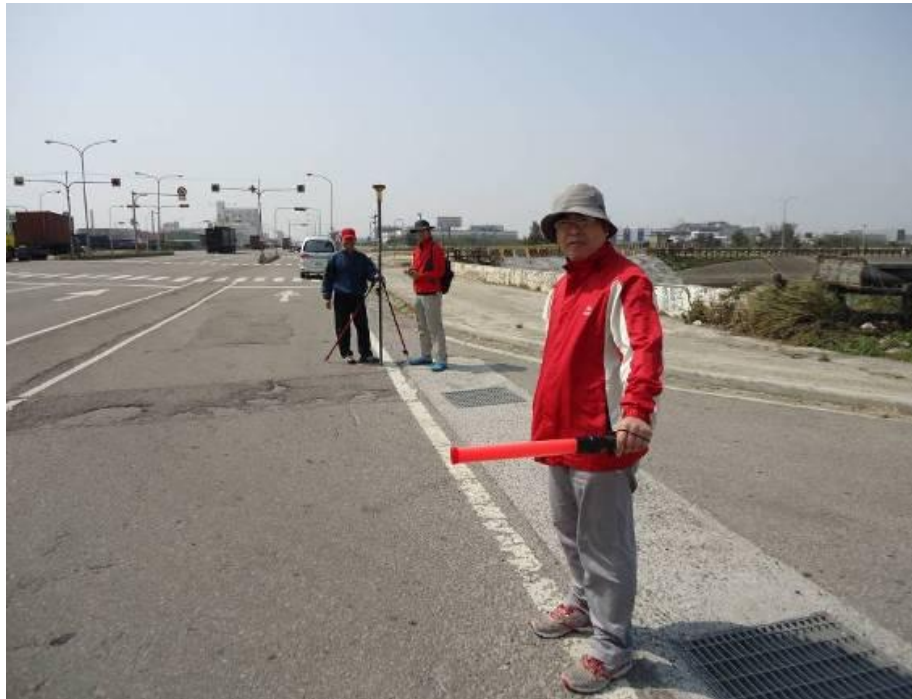
圖 3-8 臺中港儀器操作、標竿對心定平及交通安管指揮等人員
