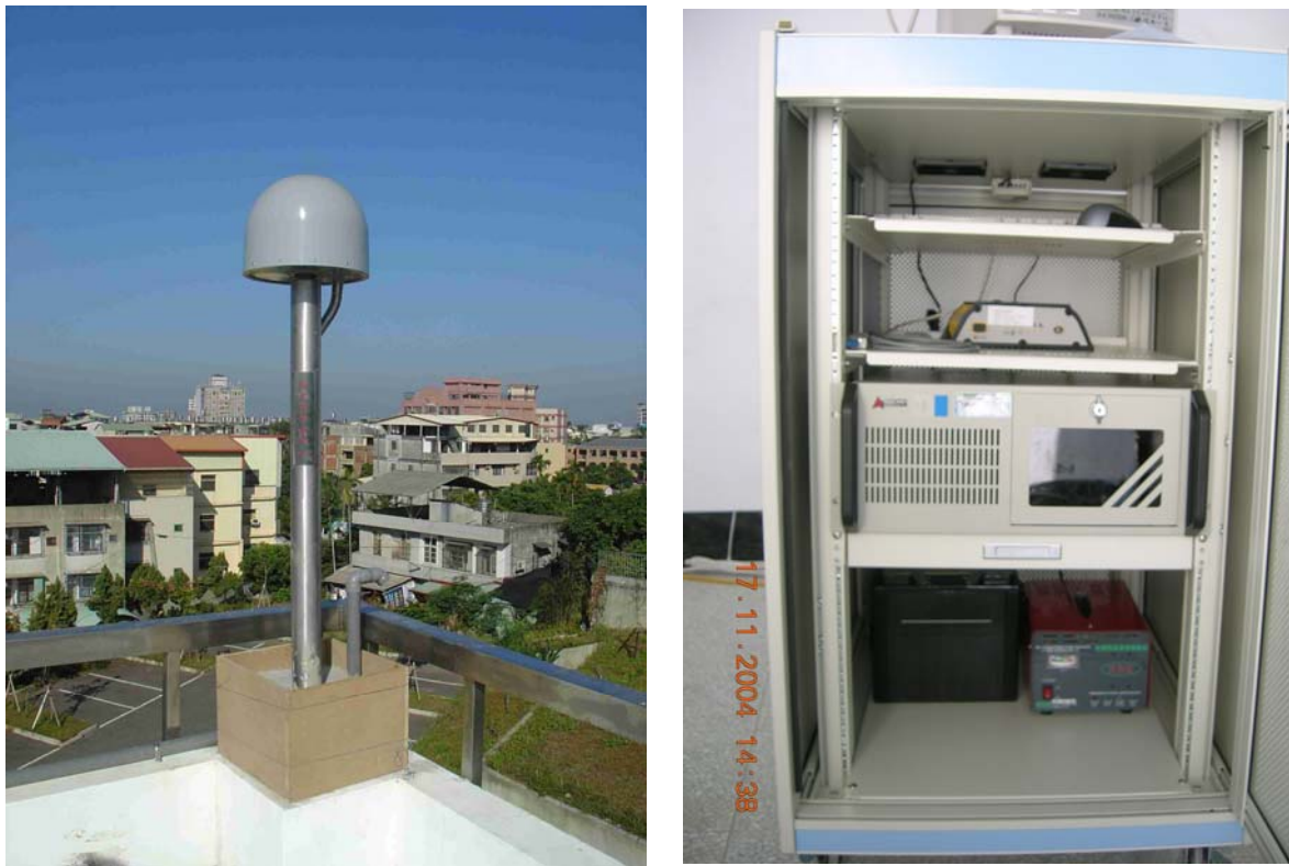
圖 3-2 鋼柱式天線架基座架設及儀器機櫃主要基本配備實景相片
